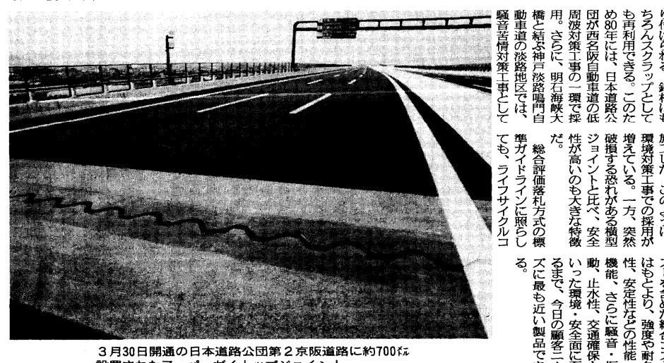
3月30日開通の日本道路公団第2京阪道路に約700枚設置されたスーパーガイトップジョイント
