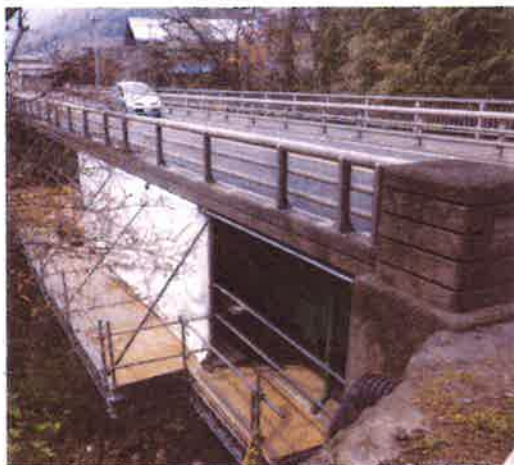
クイックラップを設置中の大国橋
