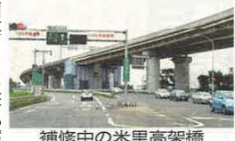
補修中の米里高架橋
