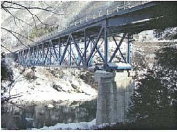
ニツ屋橋全景
