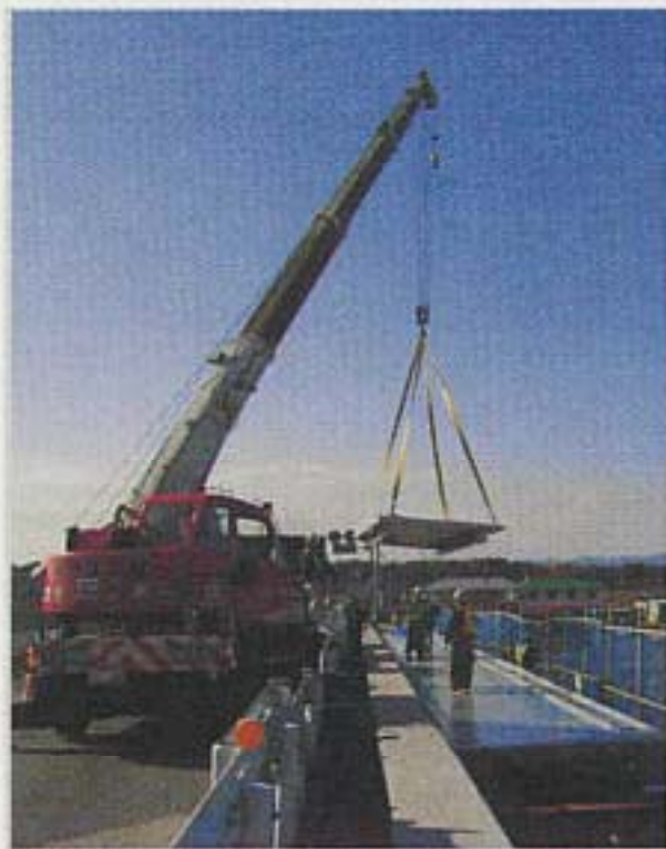
小高川橋での施工の様子
