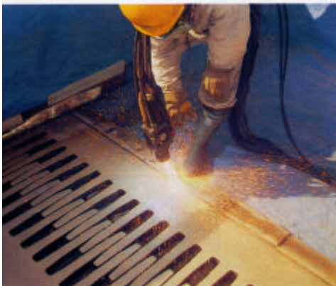
1 道路橋の路面接合部で鋼材の露出個所にアモルファス合金を溶射して滑り止めにする
