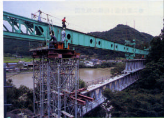
14 橋桁を分割して工場で製造。現場で組み立てて架設する。(写真：吉田 誠)
