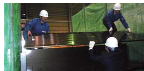
パネル自体軽量であるため、人力による施工が可能
