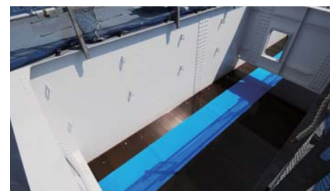
施工直後でも突起が少なく、フラットな仕上がり
