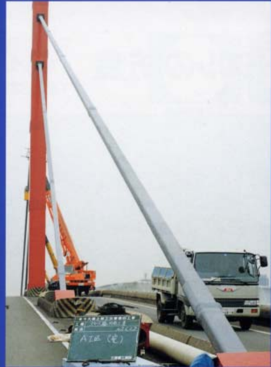
摩耶大橋（兵庫県）
