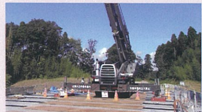
鋼殻パネル上からの架設状況
