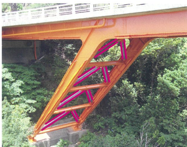
方杖ラーメン橋【既設置換え】
