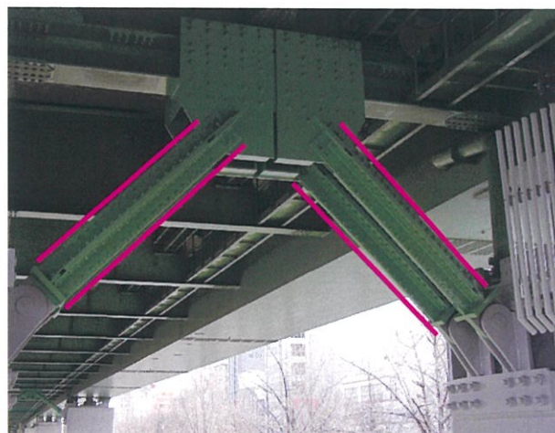
桁橋支点部【新規に設置】
