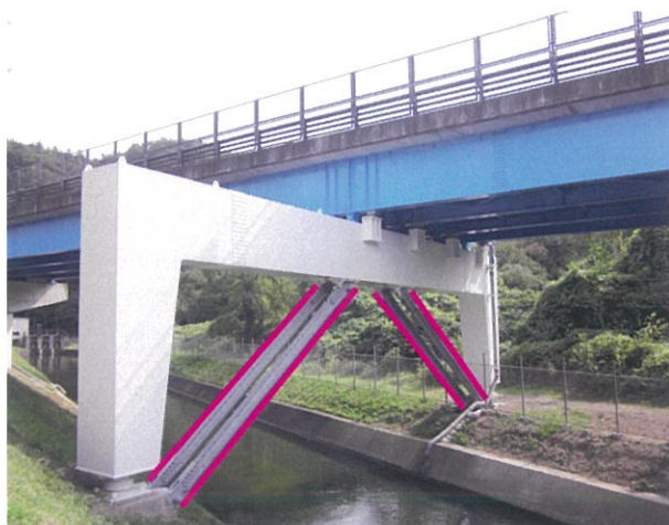
門型鋼製橋脚【新規に設置】
