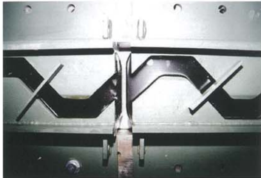
製品連結部はシール材を張り出し圧着
