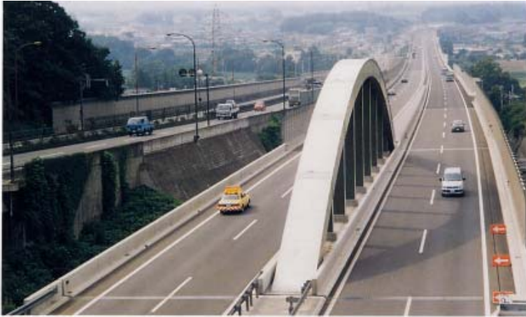
圏央道・高架橋(埼玉県)
