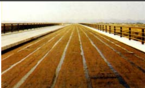
防水層施工完了
