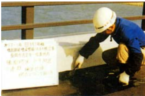
網状ルーフィングによる端末処理
