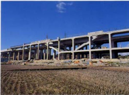
名鉄電車高架橋(愛知県)
