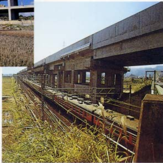
上越新幹線高架橋浦佐駅周辺(新潟県)
