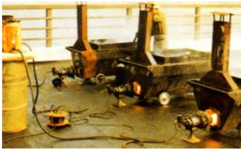
張付け用アスファルトの溶融
