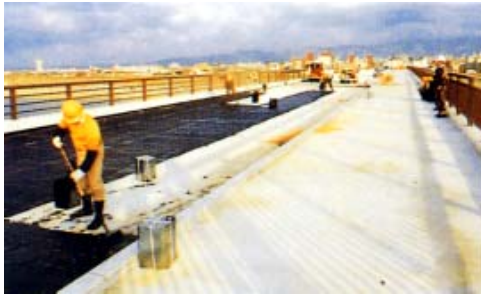
プライマー塗布
