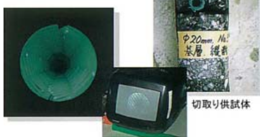
■舗装後のペーブドレーン内部
