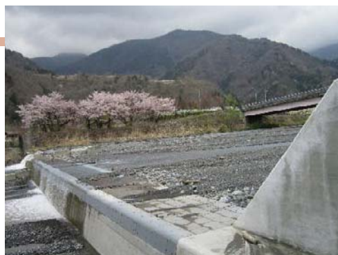
▲山梨県 御勅使川(床固工)/ライトグレー
