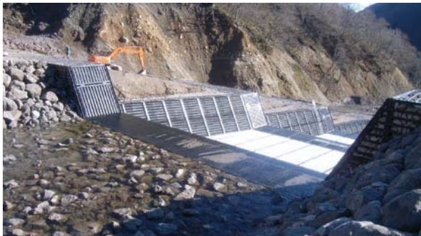
▲宮城県 湯浜床固工(鋼製枠堰堤)
