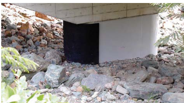
▲愛媛県 宝来橋(橋脚上流側)
