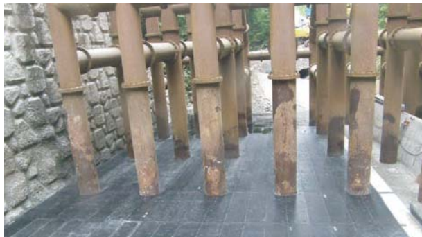
▲長野県 波田黒川(鋼製スリット底板部)
