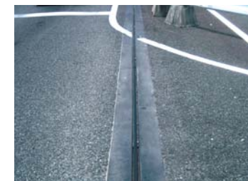
YMG-20型 縦目地部使用例
