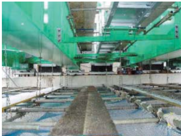
●4主鋼桁の実施工例
