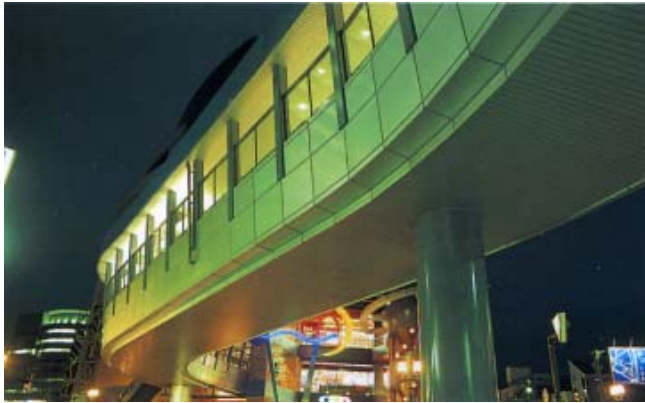
市道祇園住吉線歩道橋
