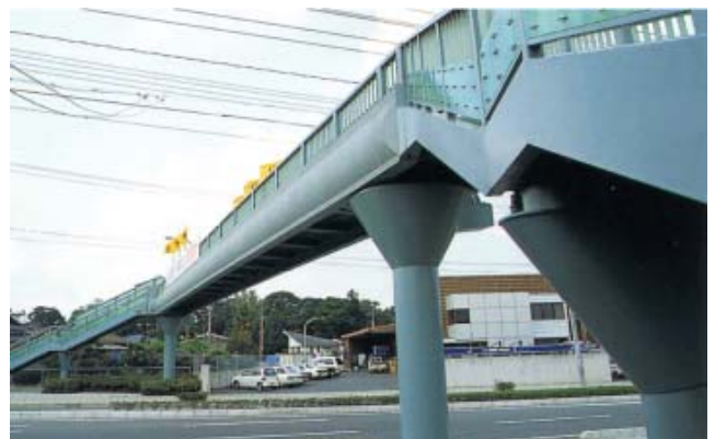
大小路歩道橋
