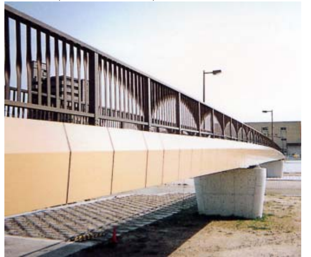
矢田川歩道橋(愛知県 尾張旭市)
