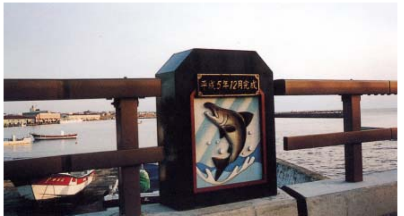
ボンコタン橋(北海道 根室市)
