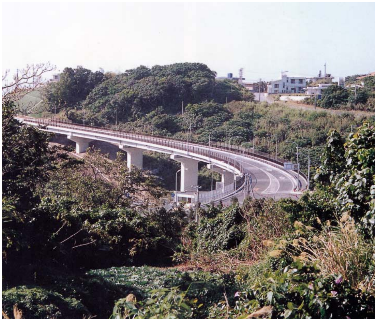
下田高架橋(沖縄県)
