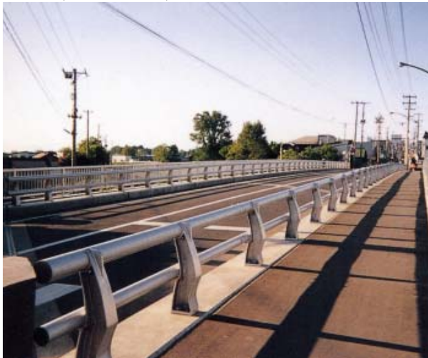
鳴沢橋(青森県 野辺地町)
