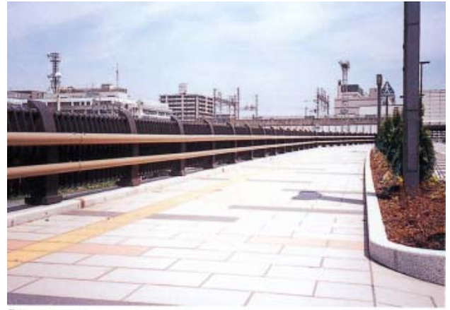
盛岡駅西口 本宮線橋梁(岩手県 盛岡市)
