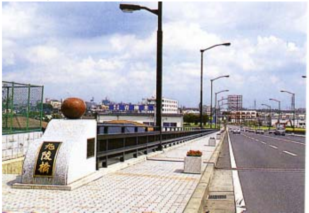
旭稜橋(栃木県 宇都宮市)
