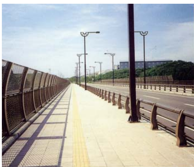
沢乙橋(宮城県 利府町)
