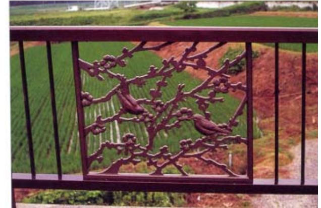
宮田大橋(千葉県 君津市)
