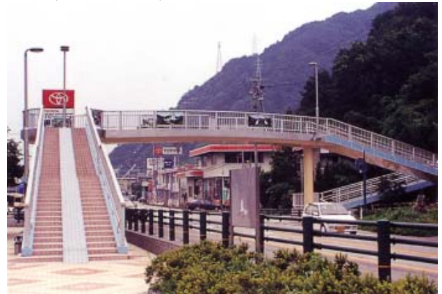
下呂歩道橋(岐阜県 下呂町)
