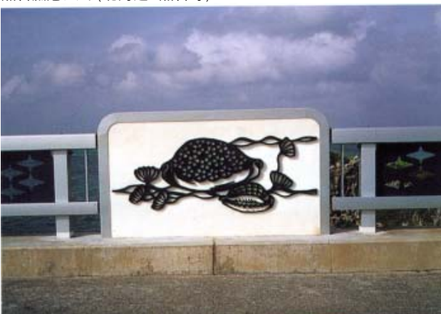
池間大橋(沖縄県 宮古島~池間島)
