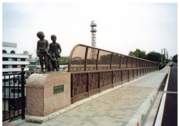
大下さくら橋(神奈川県 大和市)
