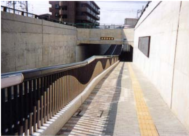
金田アンダーパス(滋賀県 近江八幡市)
