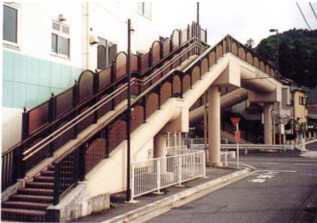
友田歩道橋 (東京都 青梅市)
