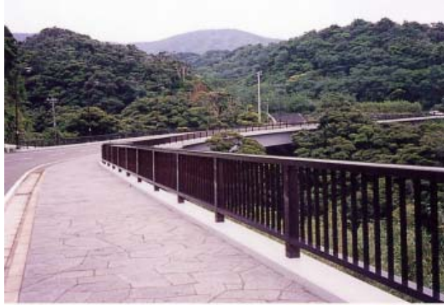
大野川橋(東京都 八丈島)
