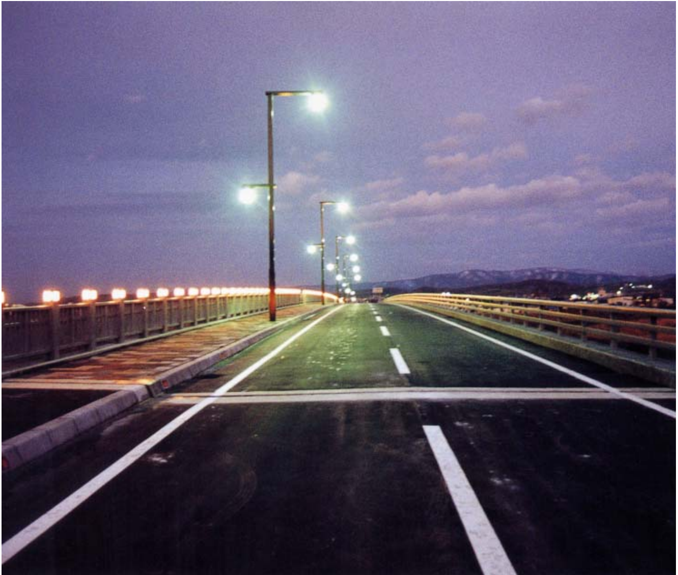
不動大橋(北海道 土別市)
