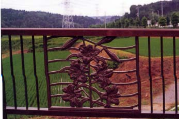
宮田大橋(千葉県 君津市)
