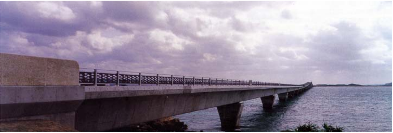
池間大橋(沖縄県 宮古島~池間島)
