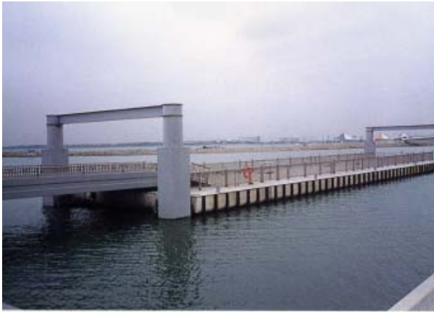
浮き棧橋(東京都 江戸川区)
