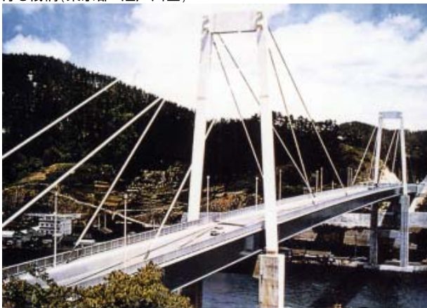
尾道大橋(広島県 尾道市)
