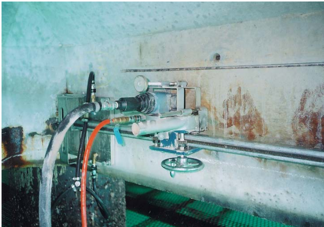
①カッター設置状況
