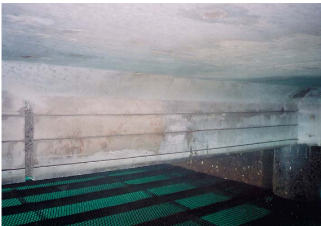
②カッター工完了
