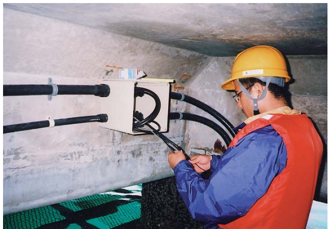
⑤ケーブル配線 / ボックス取付
