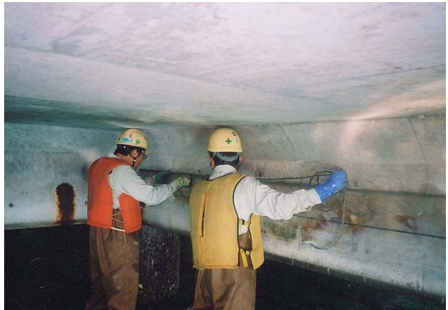
④モルタルおよび電極設置
