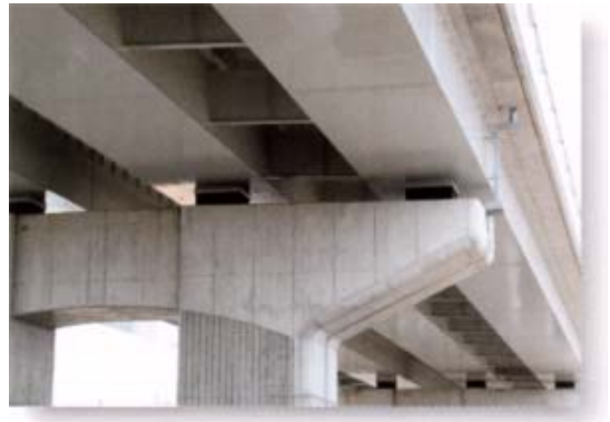
宇都宮北道路 上戸祭高架橋
