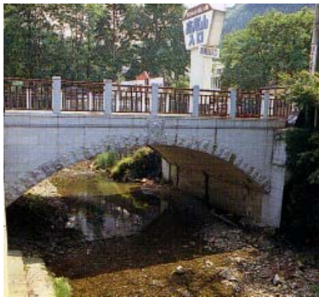
高尾橋 石張り
