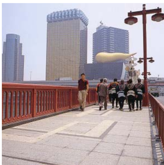
吾妻橋 高欄・照明・分離柵・石張
