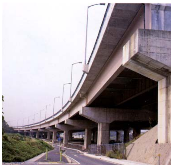
第二東名高速道路大府第一高架橋 (日本道路公団)
