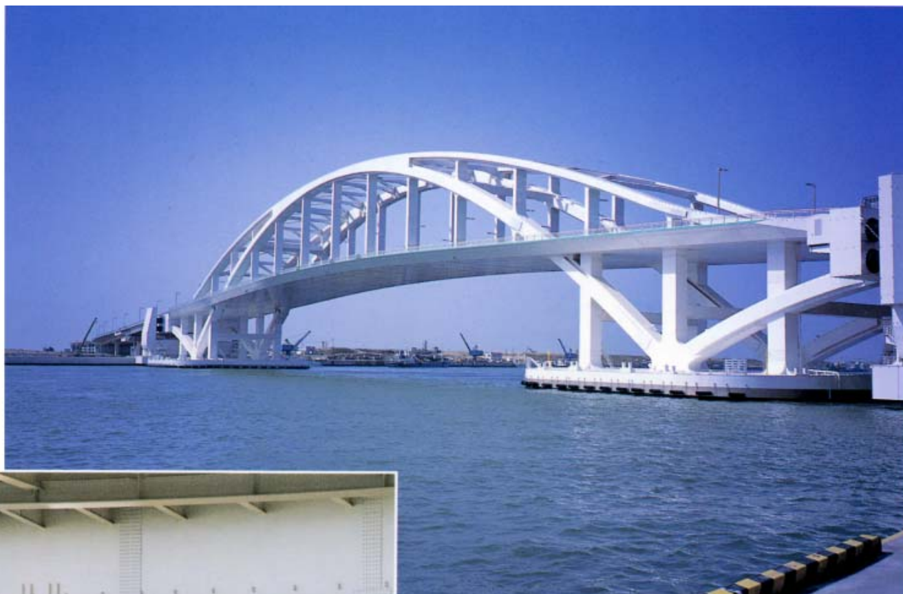
夢舞大橋(大阪市建設局)
