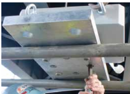
Step 2 取付プレートの接続
