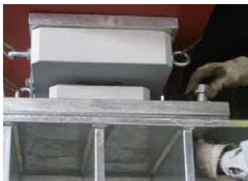
Step 5 シムプレート設置
