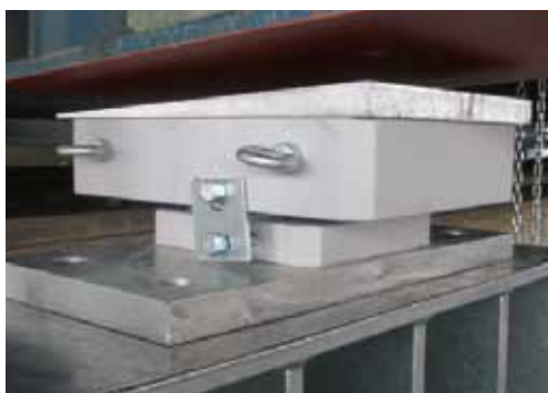
Step 4 調整プレート設置
